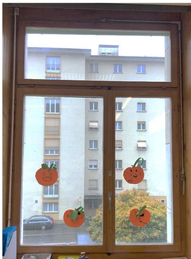
fenêtre actuelle intérieure
